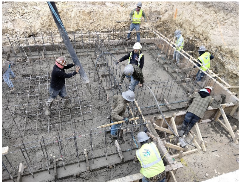
2024.02.29, Chlorine Contact/Effluent Transfer Foundation Pour
