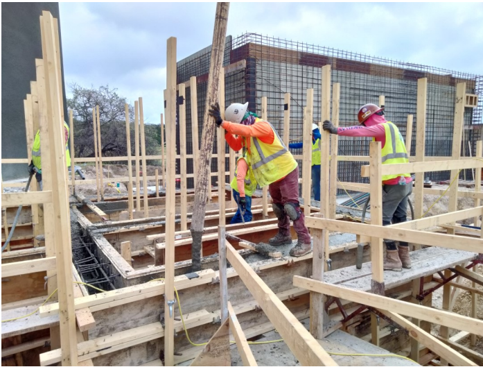
2024.03.12, CL2/Effluent Basin Wall Pour
