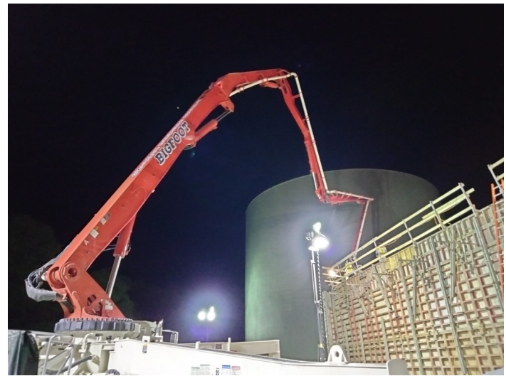
2024.03.19, Aeration Basin Wall Pour
