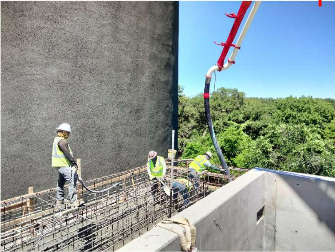
2024.04.11, Headworks Slab Pour
