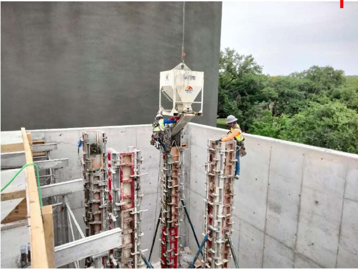
2024.04.01, Aeration West Interior Columns Pour
