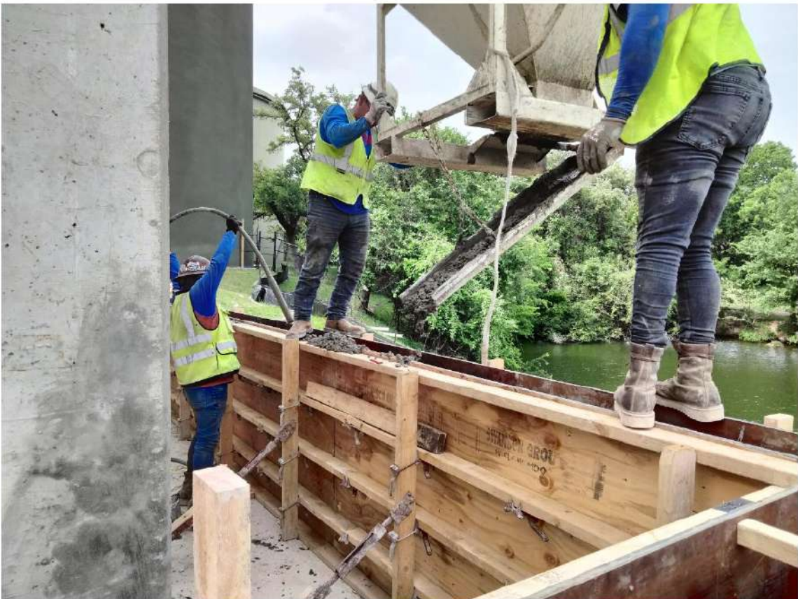
2024.04.01, Aeration Retaining Wall Pour
