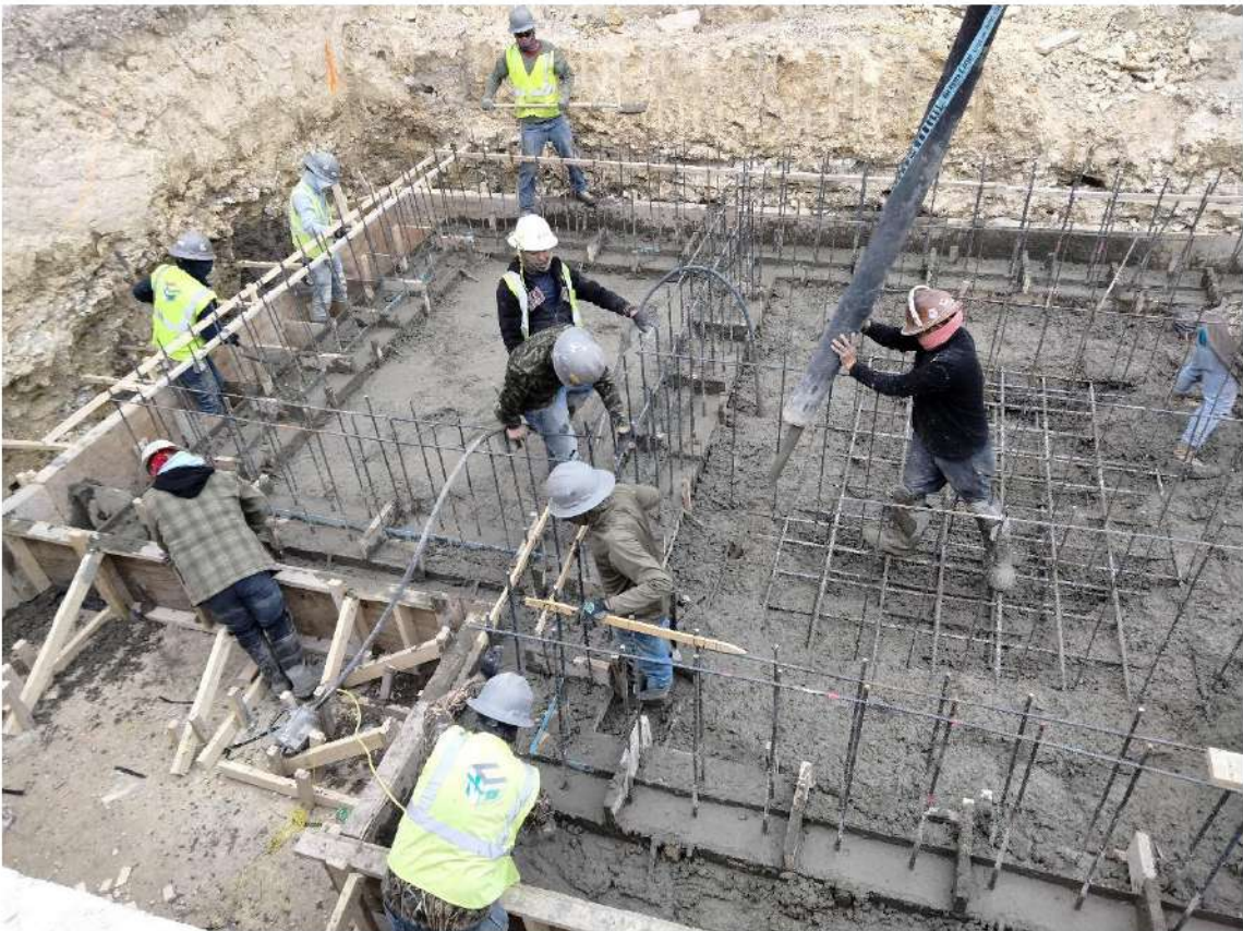
2024.02.29, Chlorine Contact/Effluent Transfer Foundation Pour
