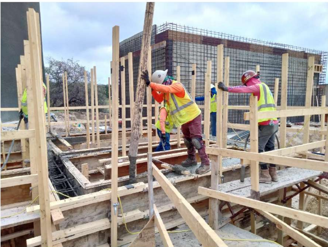
2024.03.12, CL2/Effluent Basin Wall Pour
