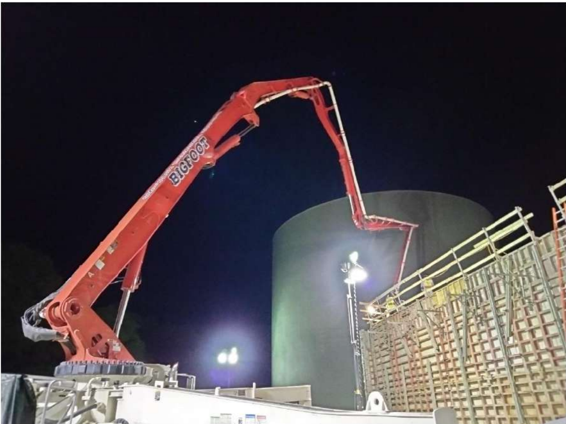
2024.03.19, Aeration Basin Wall Pour
